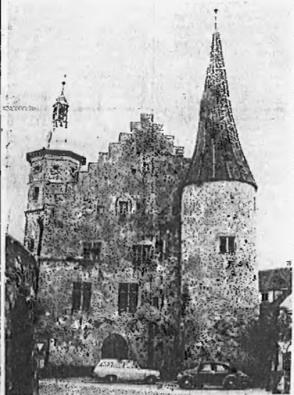
I patrizi di Sursee hanno deciso il restauro completo del Municipio. I lavori costeranno tre milioni e mezzo. Alla spesa parteciperanno la Confederazione e il Cantone di Lucerna.
